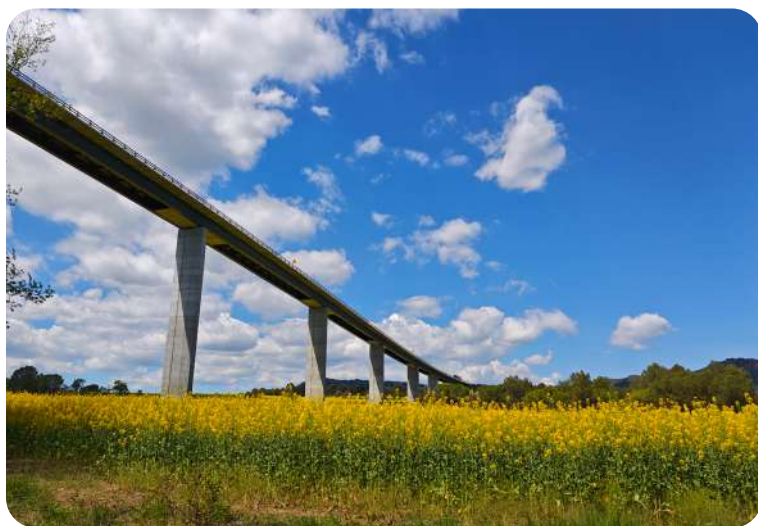
El viaducte de Rajadell
